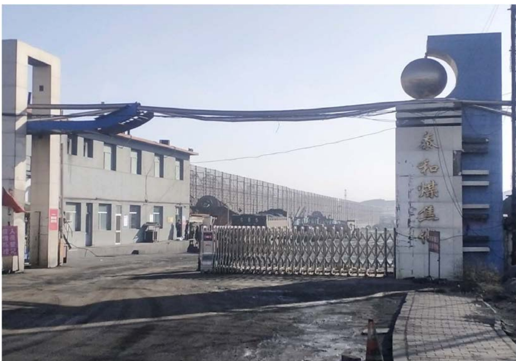
照片 3-2 园区现状
