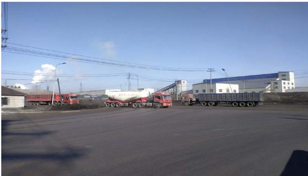
照片 3-1 园区现状
