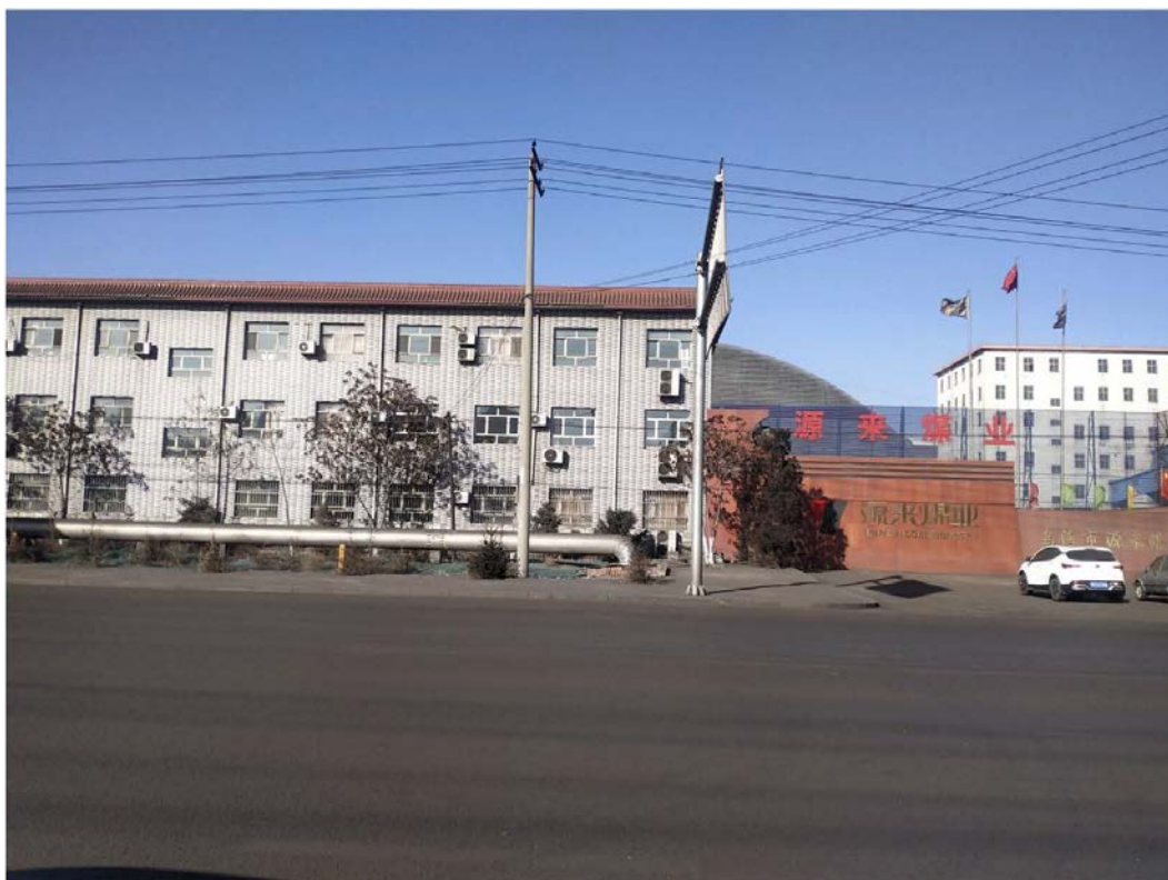
照片 3-4 园区现状
