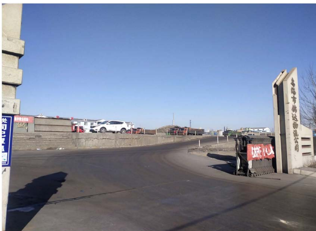
照片 3-6 园区现状
