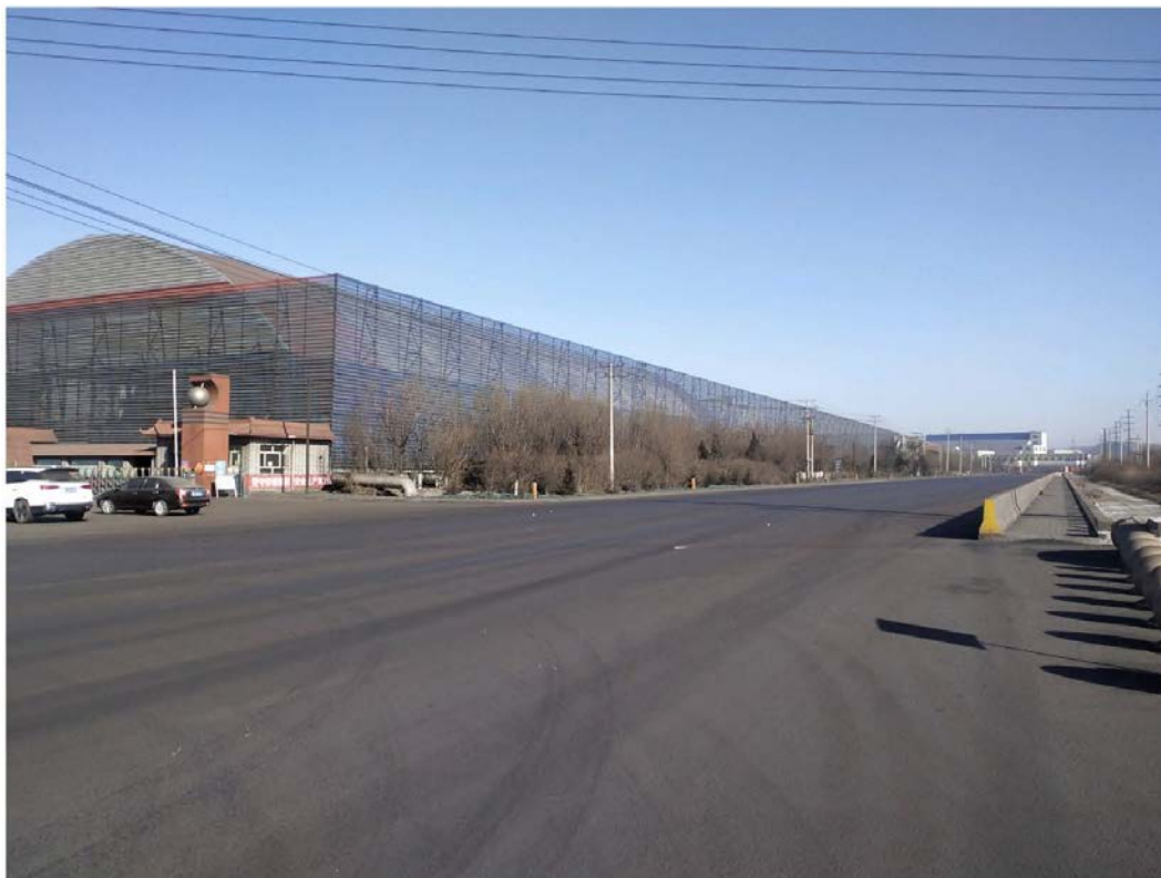
照片 3-3 园区现状
