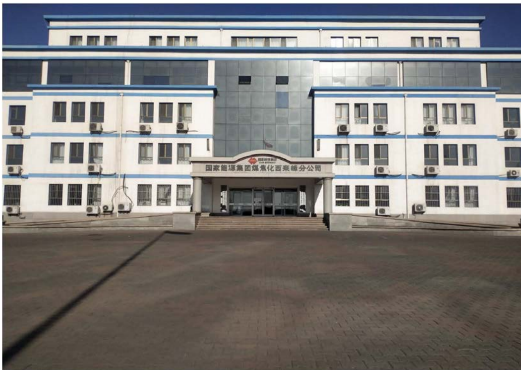
照片 1-4 国家能源集团煤焦化有限责任公司
