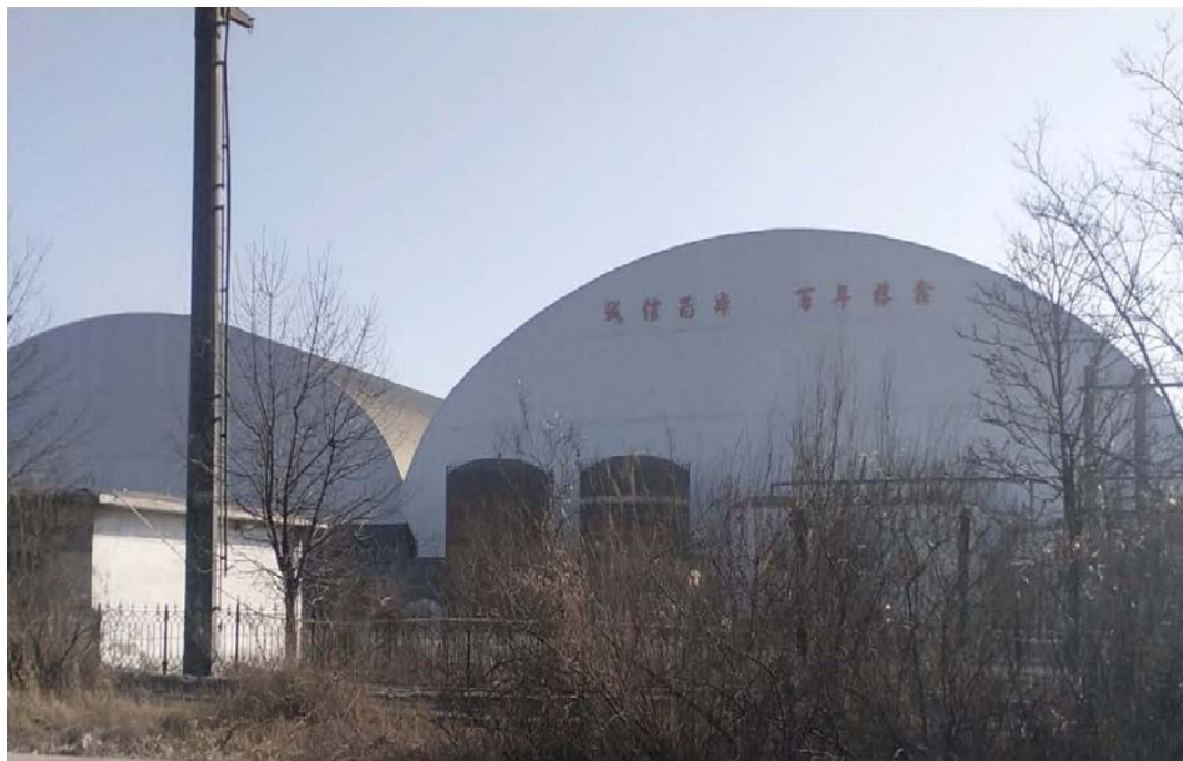
照片 3-5 园区现状
