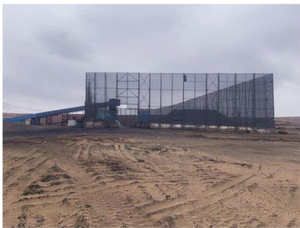
四采区临时储煤
