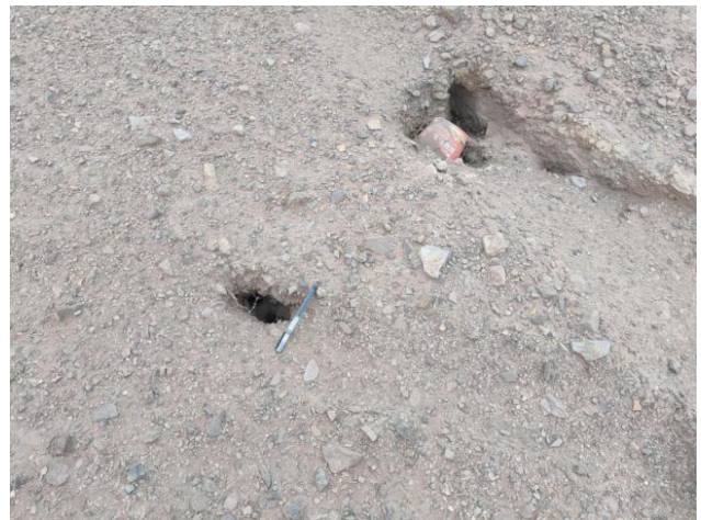
采空区地裂缝图
