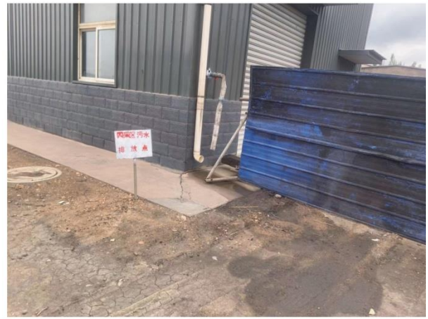
生活污水处理站
