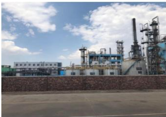
厂区西侧（信嘉化工）
